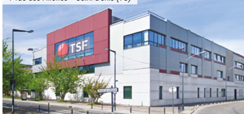
9 rue des Fillettes – Saint-Denis (93)
