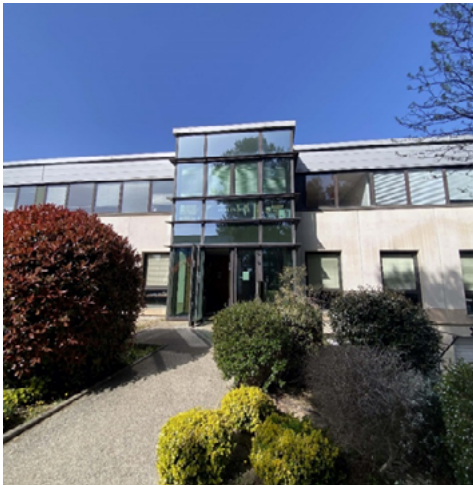
Bureaux «Le Sirocco» - Aix-en-Provence
